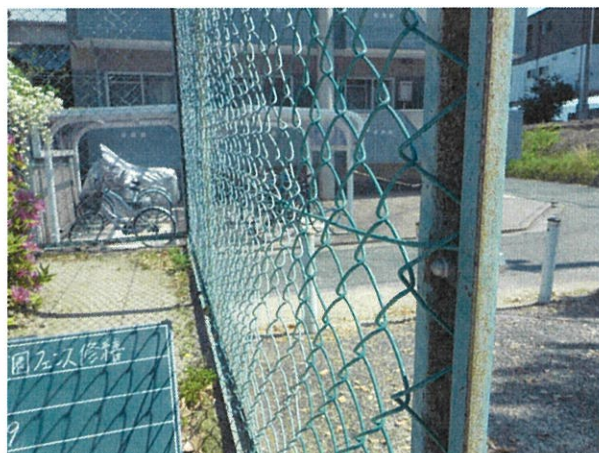
ボルト処置後
