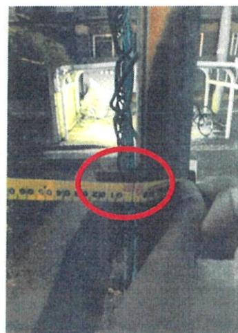
ボルト突出状況
