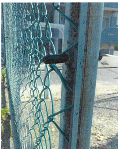
ボルト応急処置状況
