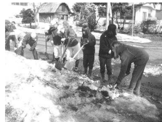
【通学路の除雪作業】
